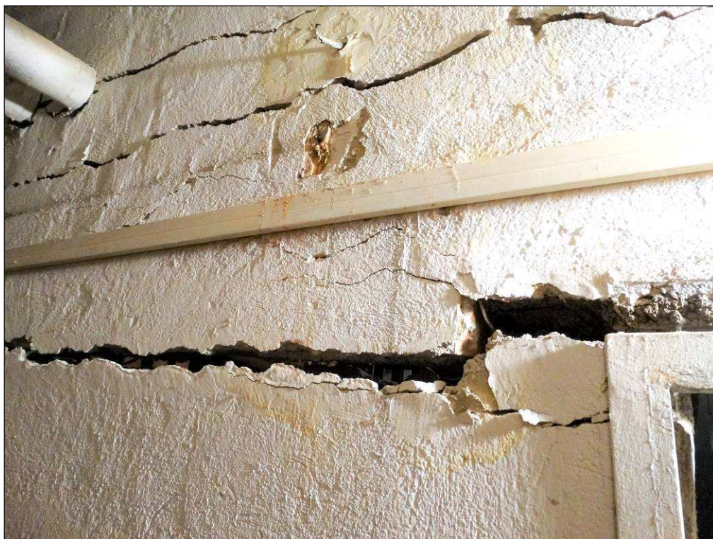
Foto č. 3 – Široká vodorovná trhlina ve stěně.
