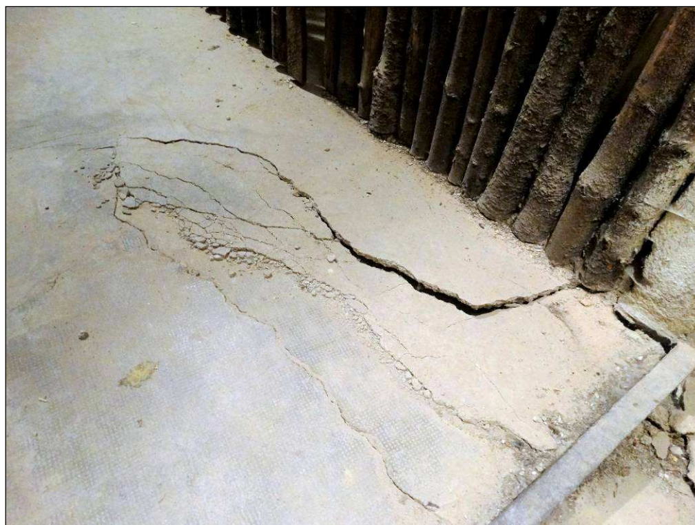
Foto č. 4 – Prosednutá a popraskaná podlaha za dveřmi do další části sklepa.
